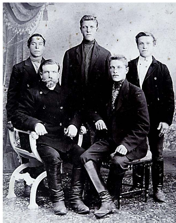
Бригада лепщиков Михаила Бубнова (в центре)
