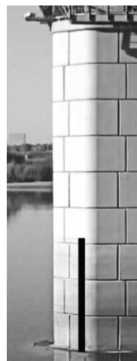
Рис. 4. Амплитуда колебаний уровня воды летом 2016 г. (высота черной рейки) составила около 450 см. Высшему уровню соответствовал расход 3400 \text{ м}^3 в секунду (конец мая), низшему — расход 860 \text{ м}^3 в секунду (конец сентября); видны следы от осевшего на бетон ила
