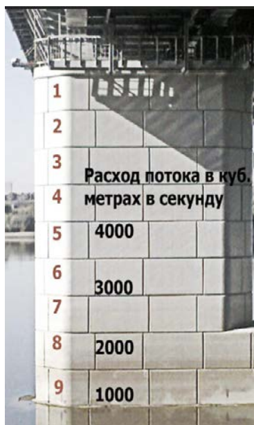
Рис. 5. Руслловая опора метромоста по ул. Фрунзе у правого берега Иртыша
